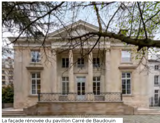
La façade rénovée du pavillon Carré de Baudouin
